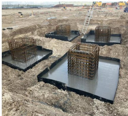
Construction de semelles isolées
