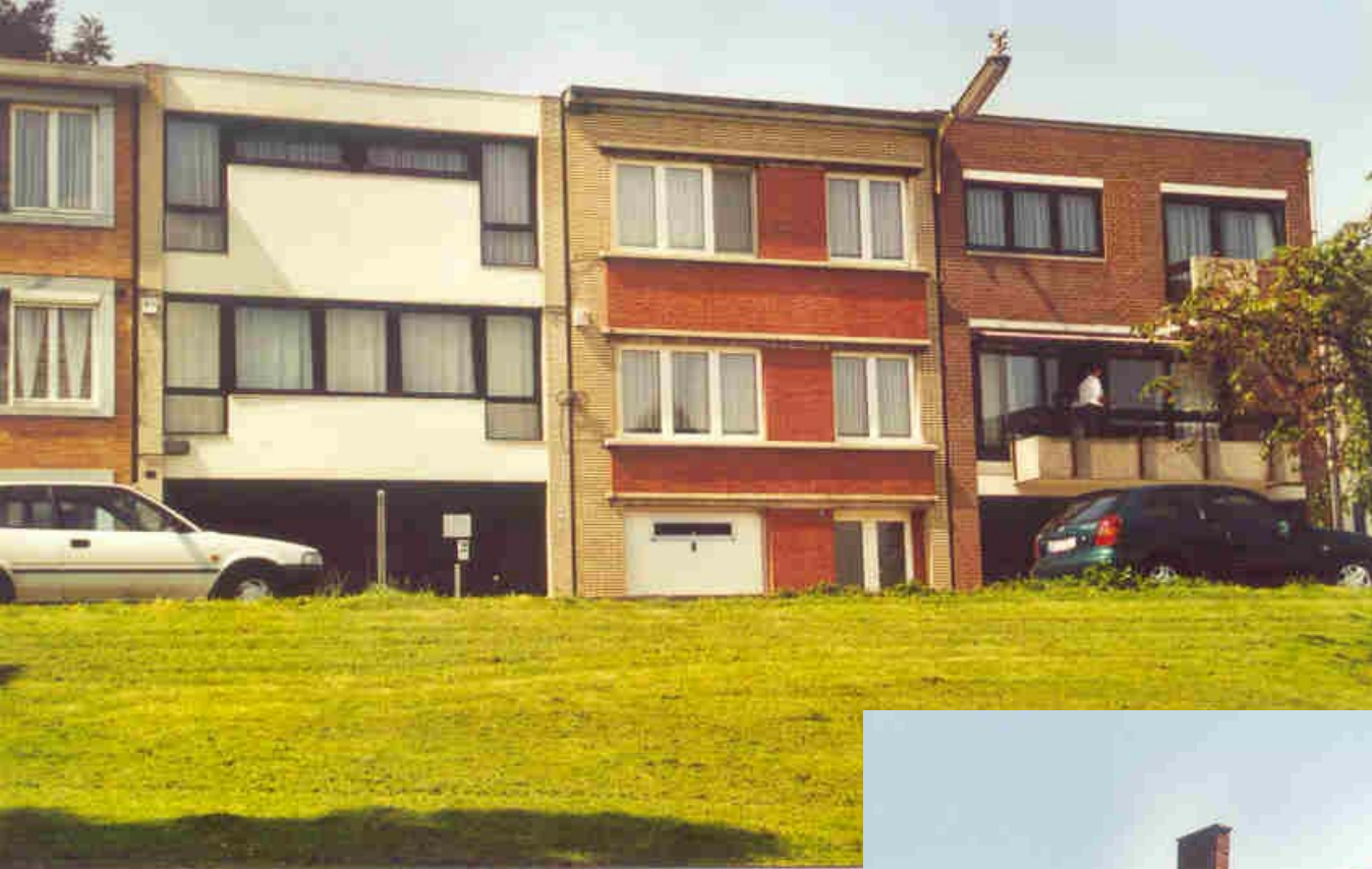
Type 2: Batiment en maçonnerie Avec plancher en béton armé (après 1940)
