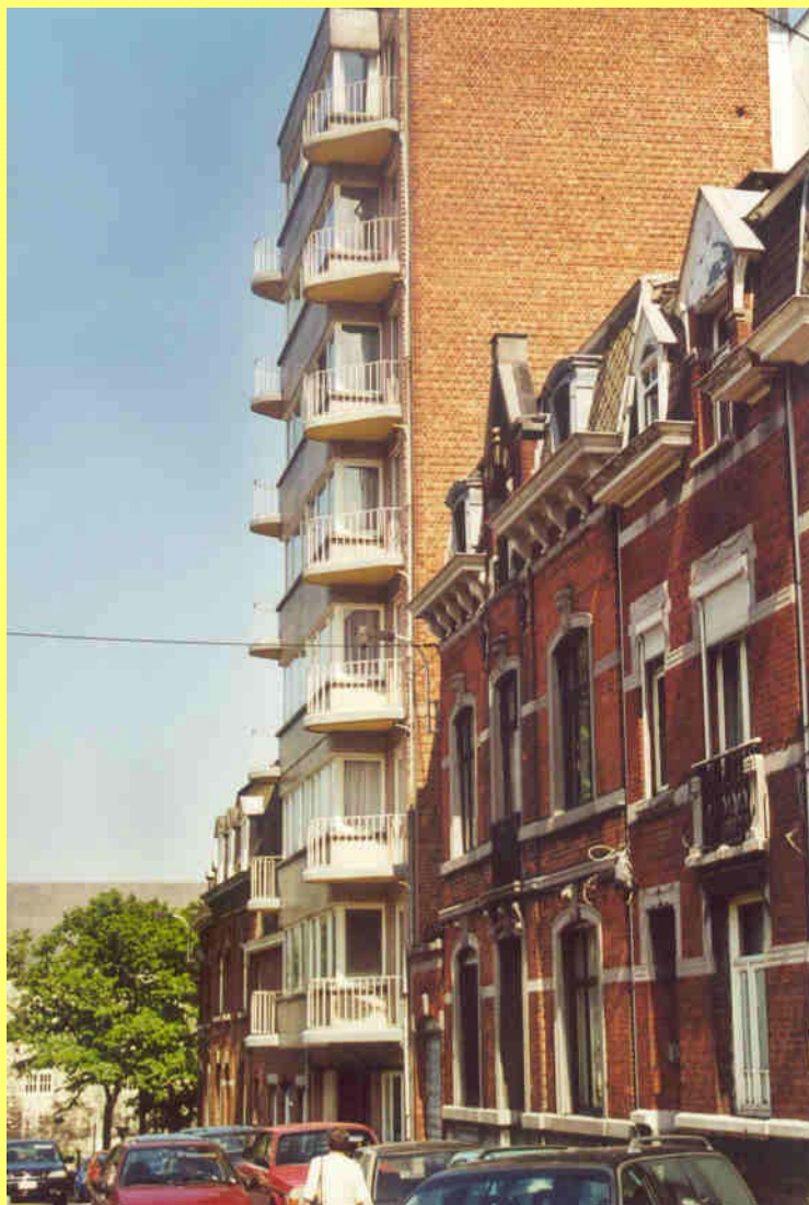
Type 3: Batiment de + de 5 étages en B.A. ou Mixtes B.A.-maçonnerie
