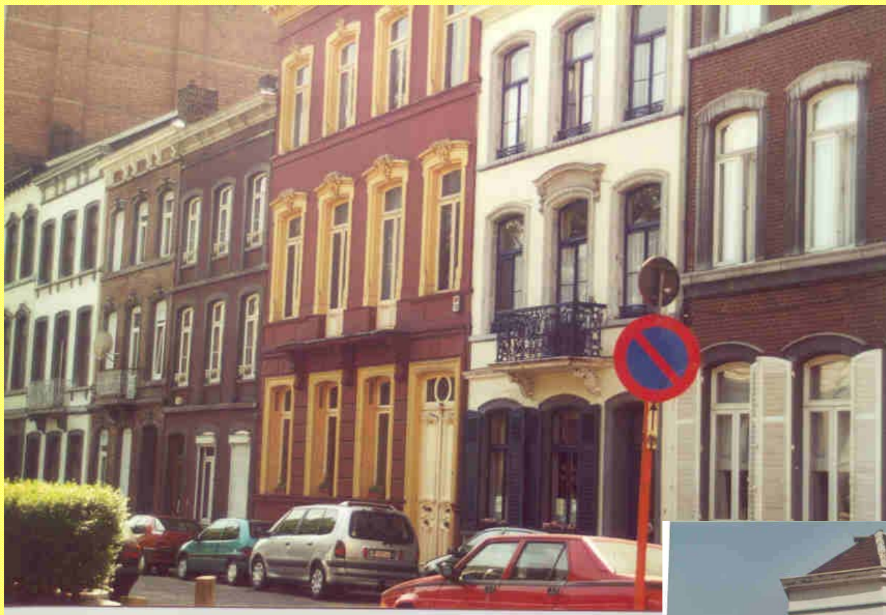
Type 1 Bâtiments en maçonnerie avec plancher en bois (= avant 1940)
