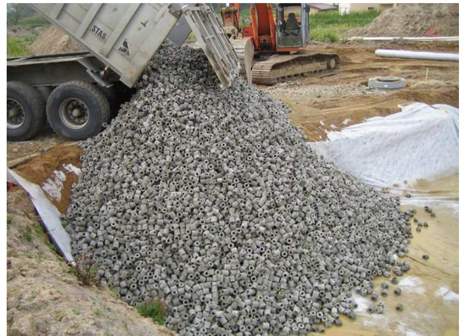
**Béton non structurant pour chaussée réservoir**
